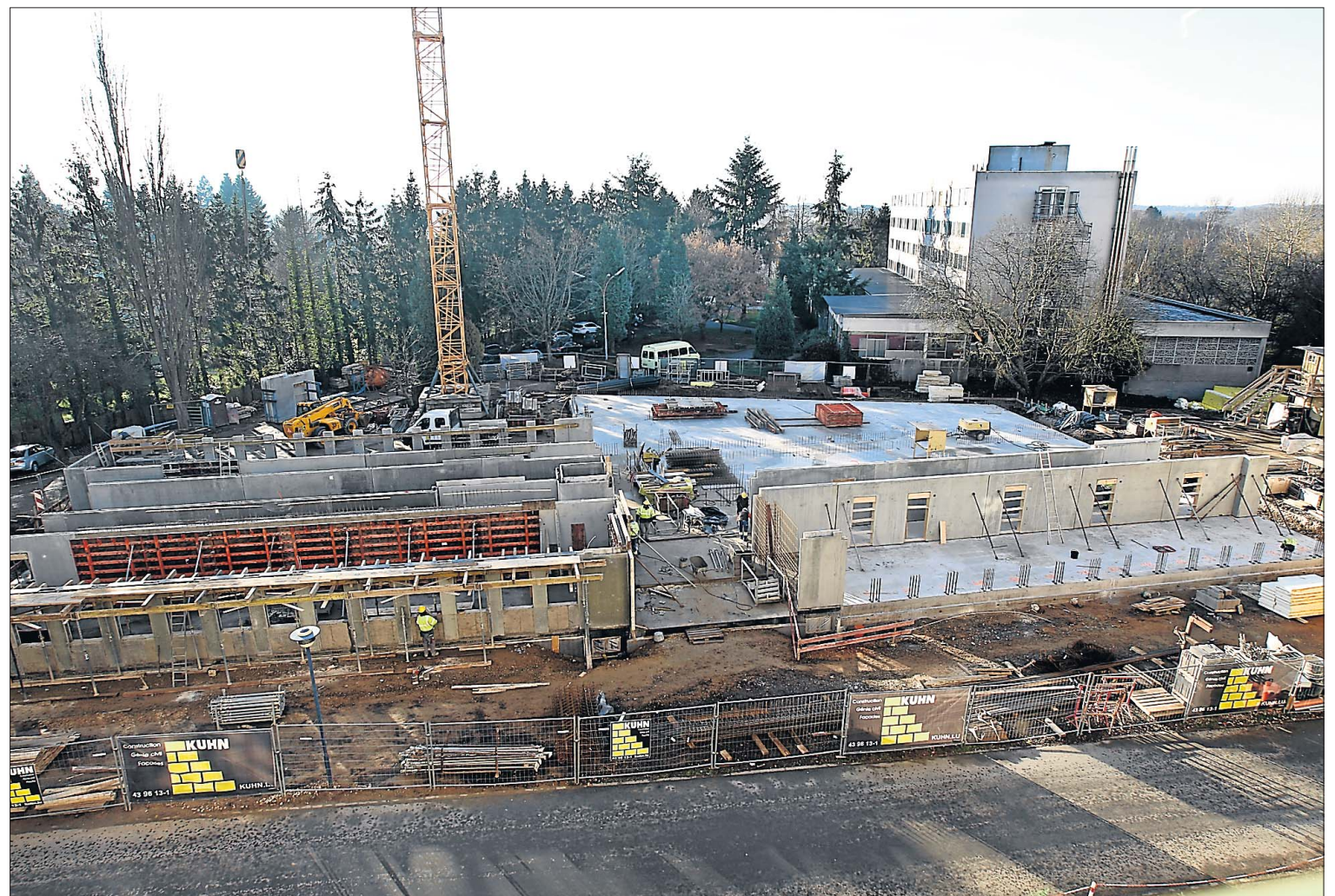
Noch immer leben um die 130 Asylbewerber in den heruntergekommenen Räumlichkeiten des alten Foyers (im Hintergrund rechts). Abgerissen werden kann es erst, wenn das neue Heim fertiggestellt ist.
